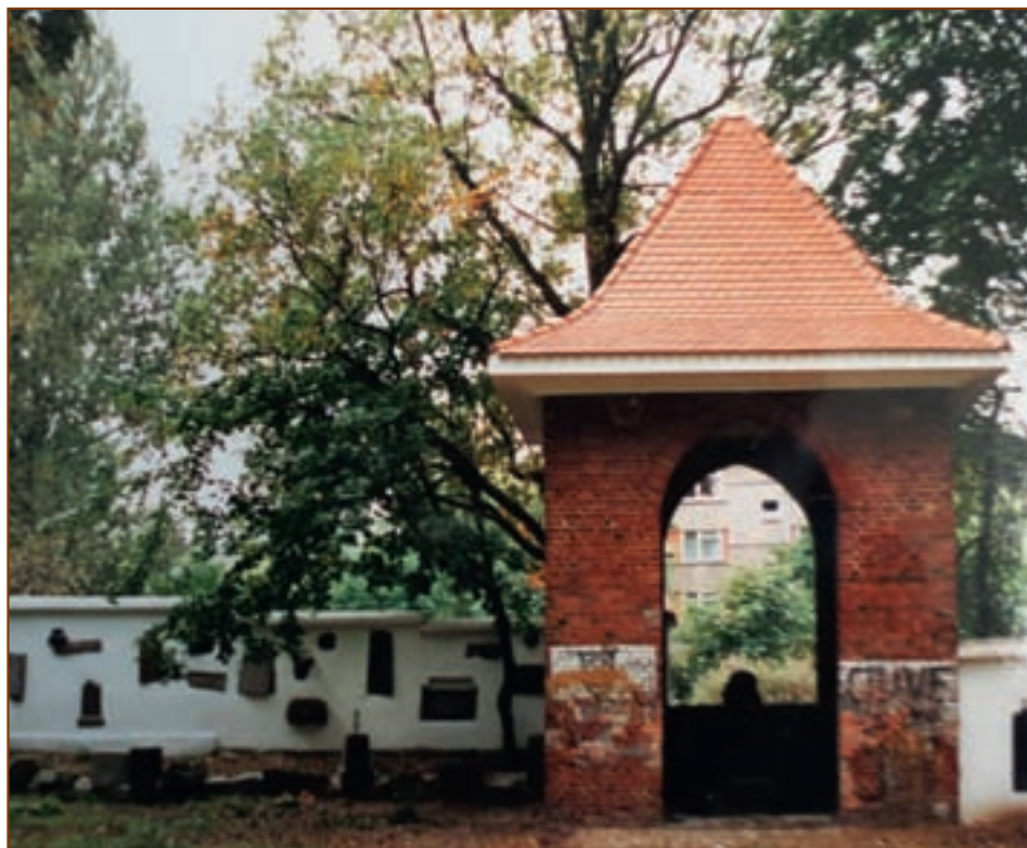
Ryc. 79. Kaplica pamięci na cmentarzu ewangelickim w dzielnicy Wygoda po rekonstrukcji dachu, przed rozpoczęciem prac renowacyjnych ścian i pomnika mieszczącego się wewnątrz kaplicy; stan w 1995 r. Odtworzony dach jest znacznie wyższy od pierwotnego pokrycia kaplicy. W zwieńczeniu zamontowany został żeliwny krzyż nagrobny pozyskany z terenu cmentarza
