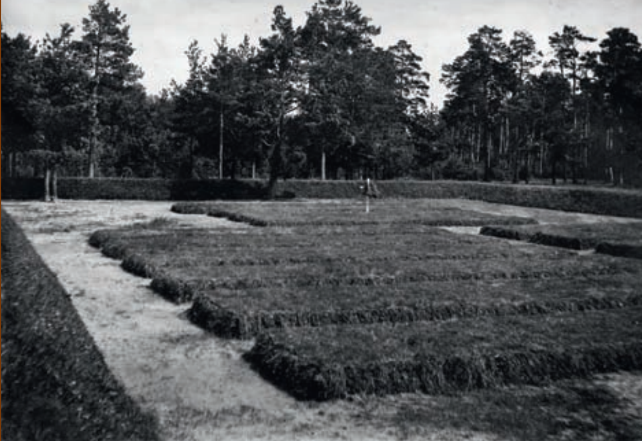
Ryc. 29. Cmentarz we wsi Podjazowle, ob. w obwodzie brzeskim na Białorusi. Wnętrze cmentarza wojennego, z regularnie rozplanowanymi mogiłami zbiorowymi, zostało otoczone wałem ziemnym. Wał i nasypy grobów są świeżo zadarniowane trawą. 1917 r.
