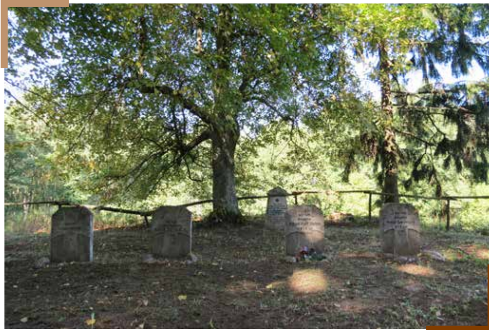
Ryc. 34. Romoty. Wnętrze cmentarza po uprzątnięciu gałęzi i liści, przed przystąpieniem do prac remontowych, 2015 r.
