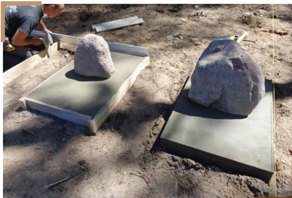
Ryc. 7. Ustawianie oczyszczonych kamieni nagrobnych na fundamentach
