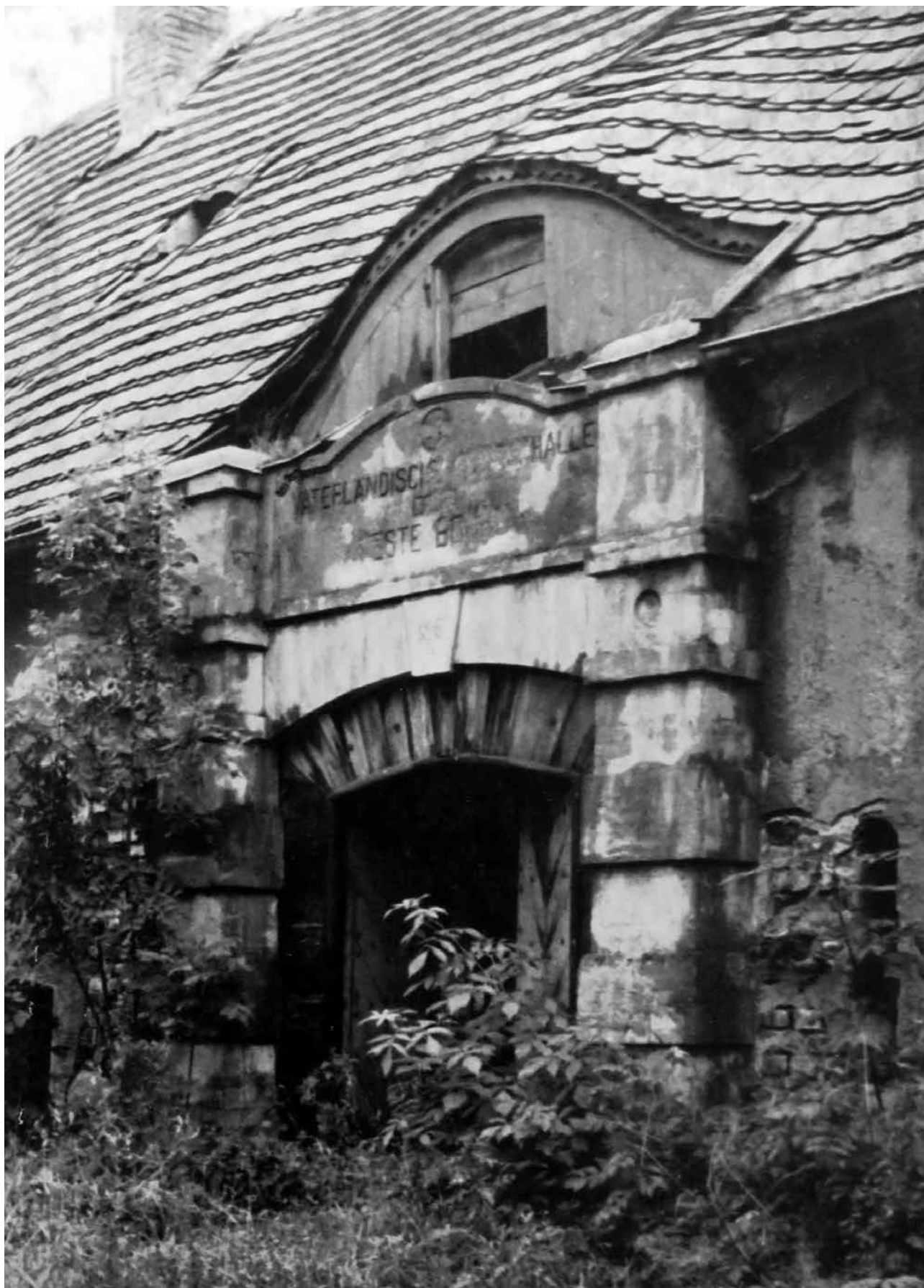
Ryc. 108: Wejście główne do budynku starej masztarni – siedziby Vaterländische Gedenkhalle Lötzen . Stan z 1950 r.
