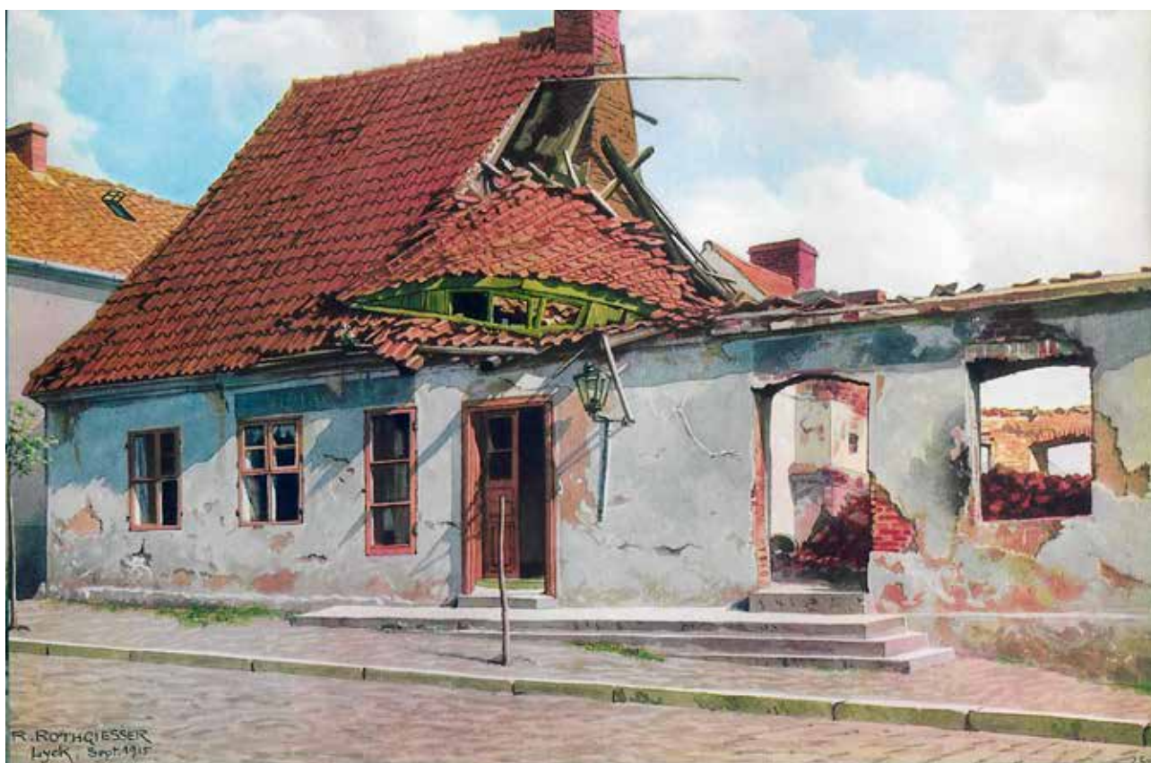
25. Eik (Lyck). Zniszczony budynek z historycznej zabudowy miasta. Ilustracja przedstawia stan z września 1915 r.
