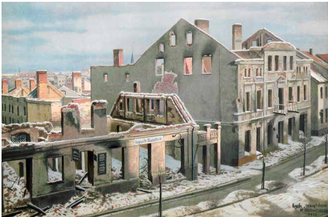
24. Eik (Lyck). Zniszczona zabudowa wzdłuż głównej ulicy największego miasta na Mazurach. Ilustracja przedstawia stan z zimy 1915 r.
