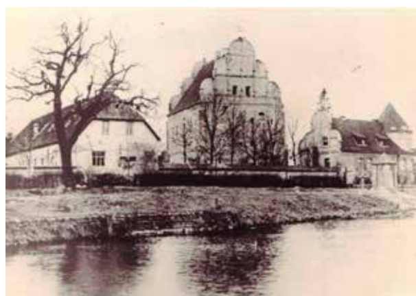
Ryc. 16: Zamek giżycki oraz budynki Vaterländische Gedenkhalle i komendatury Twierdzy Boyen około 1920 r., już po przebudowie poddasza. Widok ze wschodu na zachód
